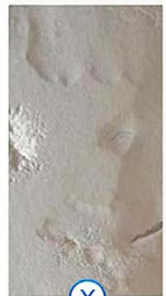
Muro abollado
